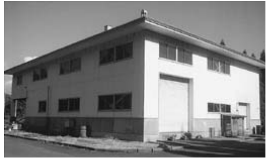
老朽化の著しいクリーンセンター
