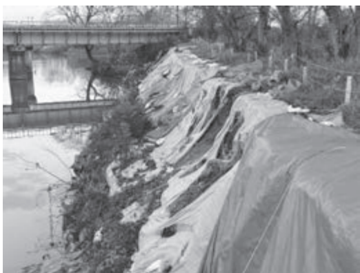
水害から3年でようやく工事着手
