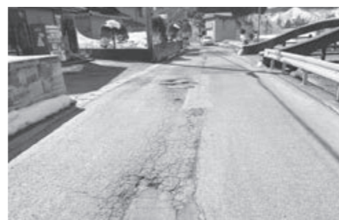
放置されている白線工事（県道4号線）
