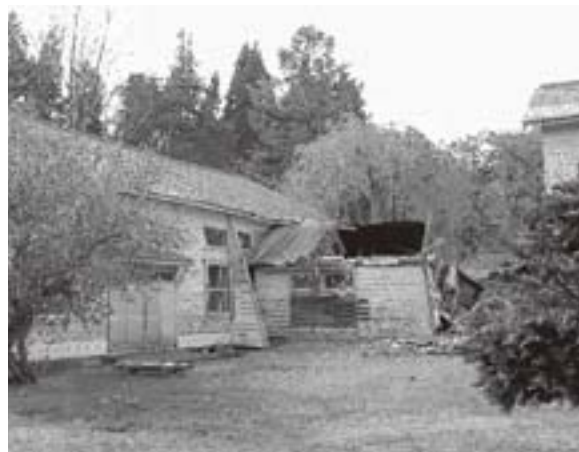
今年2月に児童玄関付近が雪の重みで倒壊した旧富津内小学校
