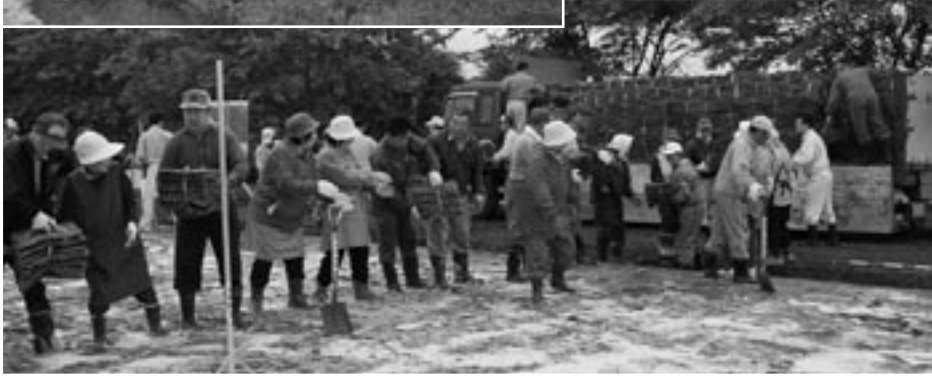
トラックから広場へ、芝の苗をバケツリレー
