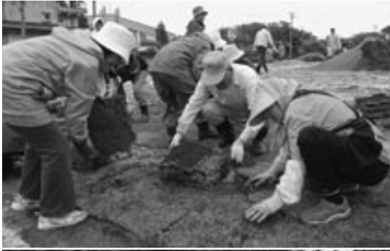
芝の苗の張り付け作業
