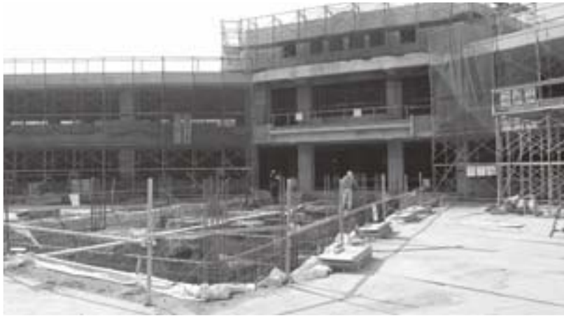
五二中建設工事の様子（六月九日撮影）
