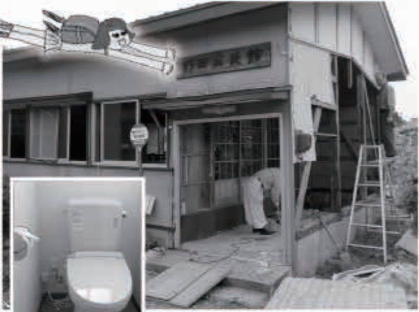
くみ取り式のトイレを水洗化、洋式化したり、段差を解消しバリアフリー化したりなど、既存集会所施設の改修も進んでいます。写真は野田町内会の野田公民館。
