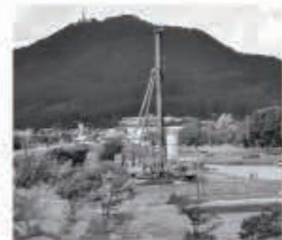
9月22日の消防庁舎建設現場
