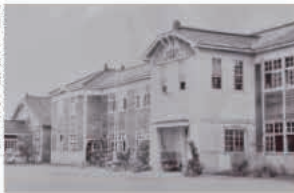
昭和8年に新築された旧校舎
