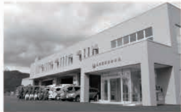
下山内に完成した新消防庁舎
