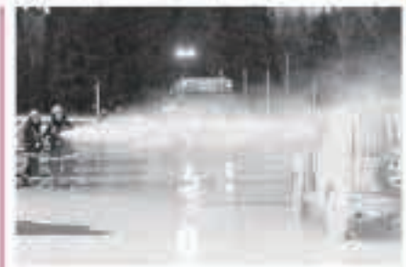
水の表面積を広げる泡消火システムで、効率よく消火することが可能に
