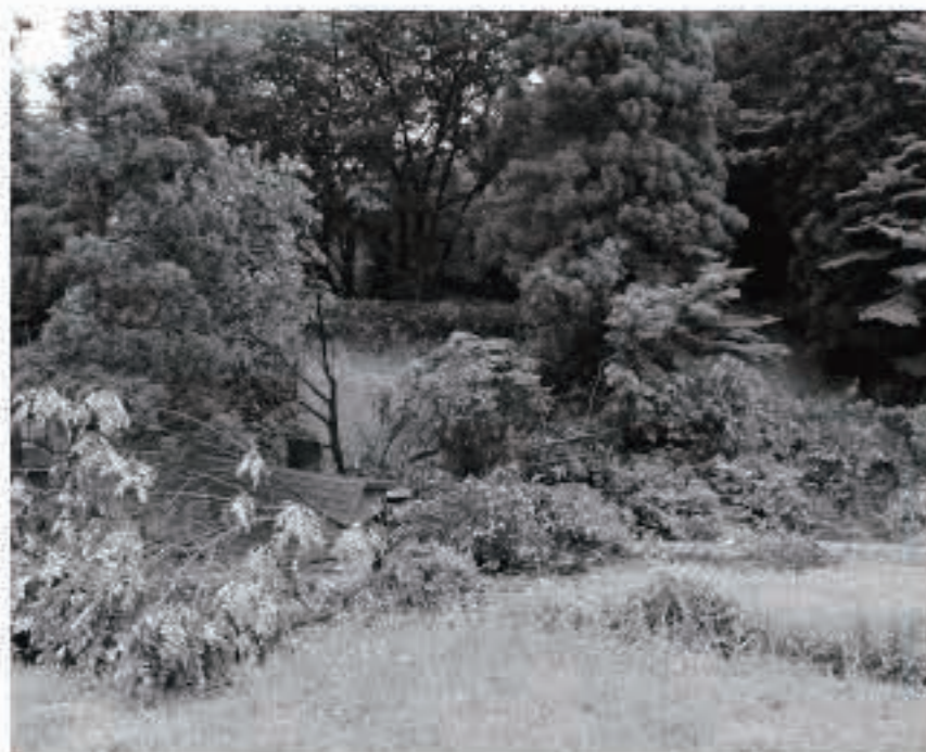
住宅に隣接する裏山が崩れ、押し出された土砂で小屋が倒壊。幸いにも人的被害はありませんでした(富津内高田)
