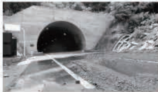
国道285号の大台トンネルは両方の入口付近ののり面が崩落し、土砂が流出
