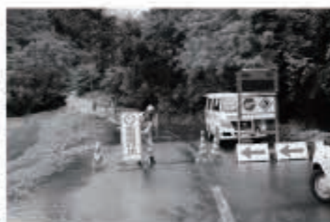
馬場目字川台の県道秋田八郎潟線では斜面が崩落し一時通行止めになりました
