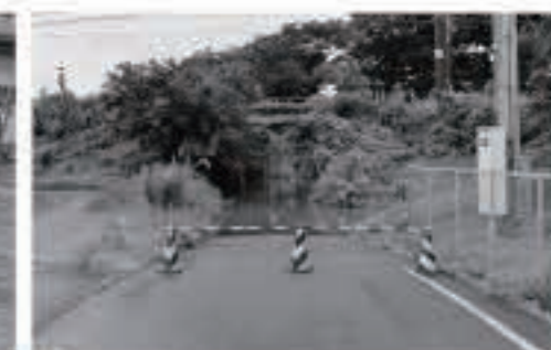
JR奥羽本線の線路下には水がたまり、一時通行不能となりました(大川下樋口)
