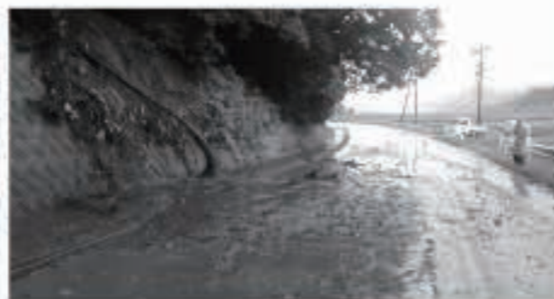
富津内富田の国道285号で道路へ土砂が流出
