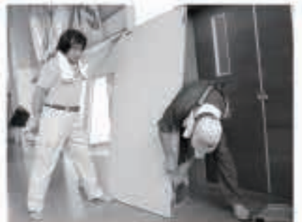
五城目小では体育館扉の調整などを行っていただきました
