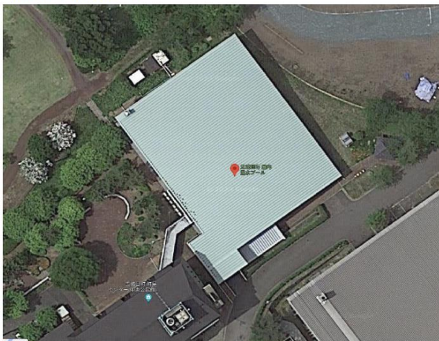
No.28 屋内温水プール
