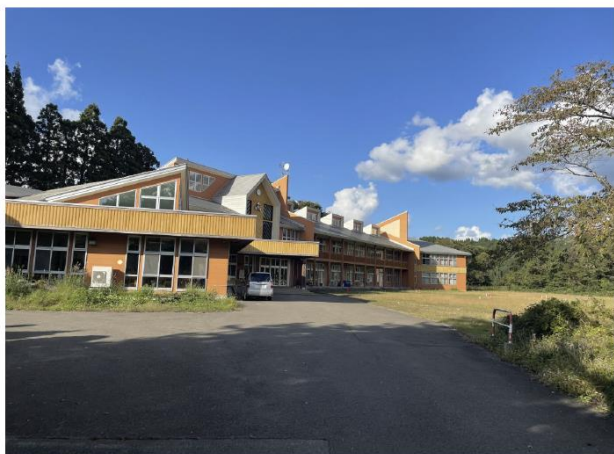
写真 地域活性化支援センター 外観
