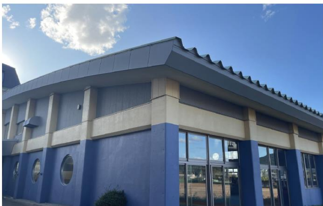
写真 屋内温水プール 外観
