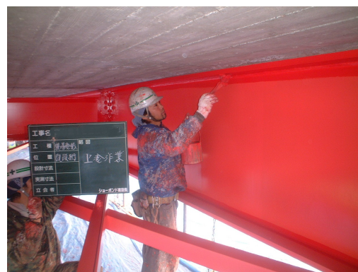
「塗り替え工上塗り作業状況」 【他自治体での事例】
