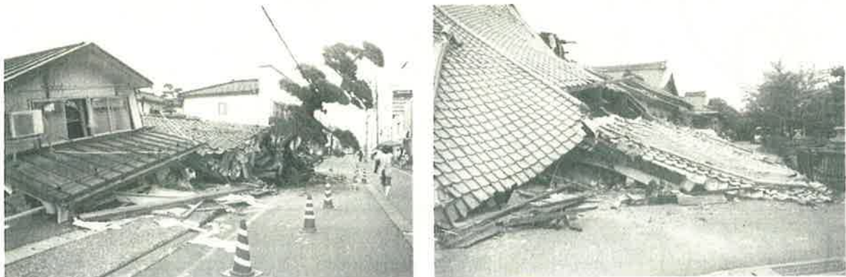
平成19年7月16日に発生した新潟県中越沖地震の道路閉塞状況
