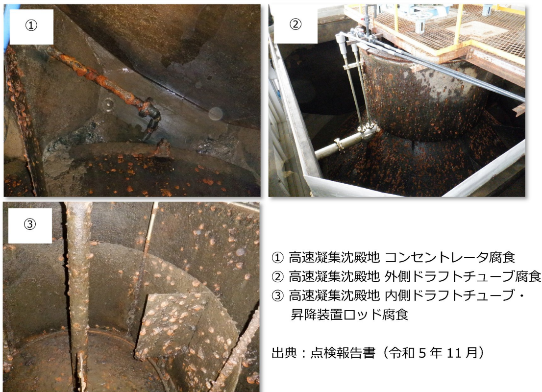
図 3.10 五城目浄水場の点検結果
