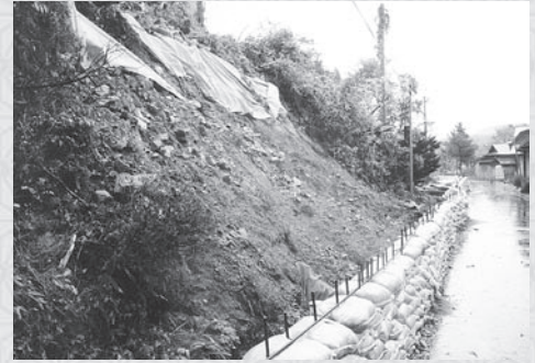
大雨で猿田沢・大ナコ地区地すべり災害が発生
