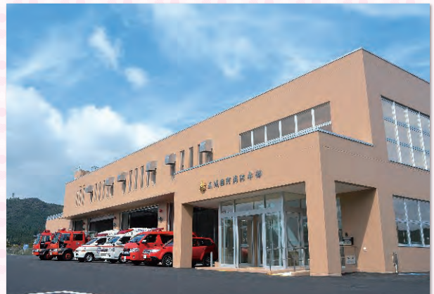
富津内下山内国道285号沿いに町消防本部庁舎と訓練棟などが完成し、老朽化していた田町の庁舎から移転し業務を開始
