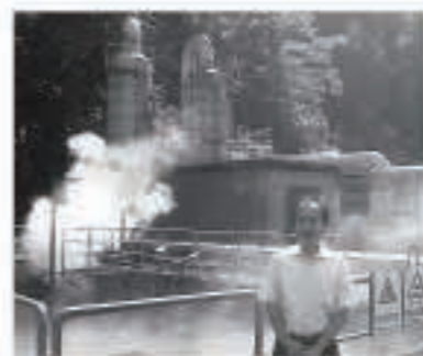
高温耐熱金属材料を使用している 県南地熱発電所の井戸にて
