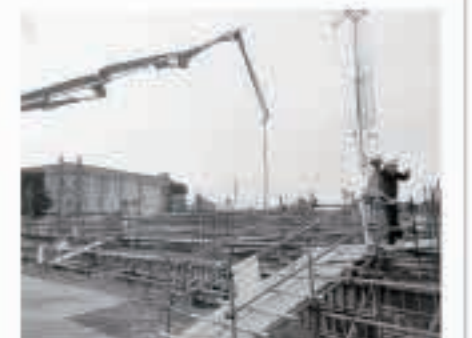
基本設計、実施設計業務を経て五城目小学校新校舎の工事を着工
