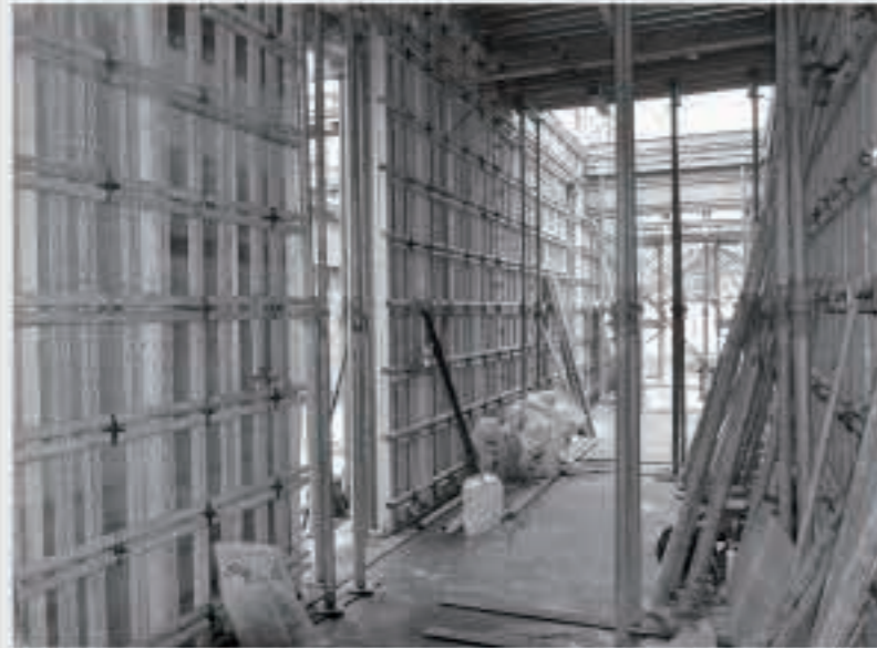
体育館からの通路部分。左側はトイレなどのスペースです。
