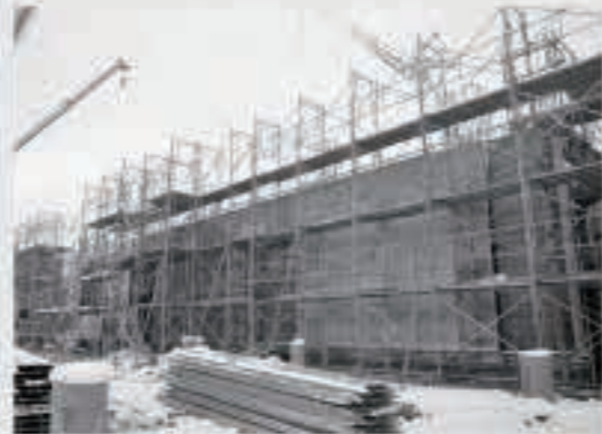
1階の壁面型枠と外部足場が立っています。1階の高さが見えてきました。
