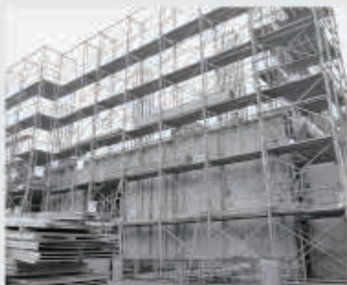
体育館の入口部分です。木製の型枠が外され、部分的にコンクリートが目視できます。
