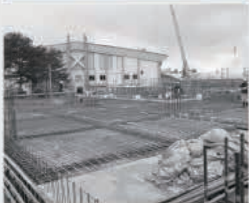
2階の床部分の工事が進められています。手前側はすでにコンクリートが固まっています。
