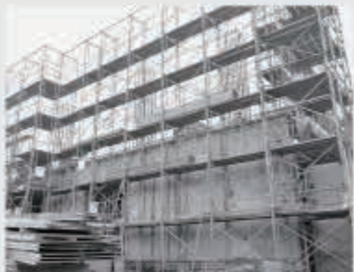
体育館の入口部分です。木製の型枠が外され、部分的にコンクリートが目視できます。
