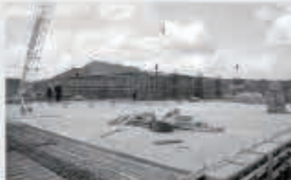
2階から見た森山の様子。3階の鉄筋を組み立てています。
