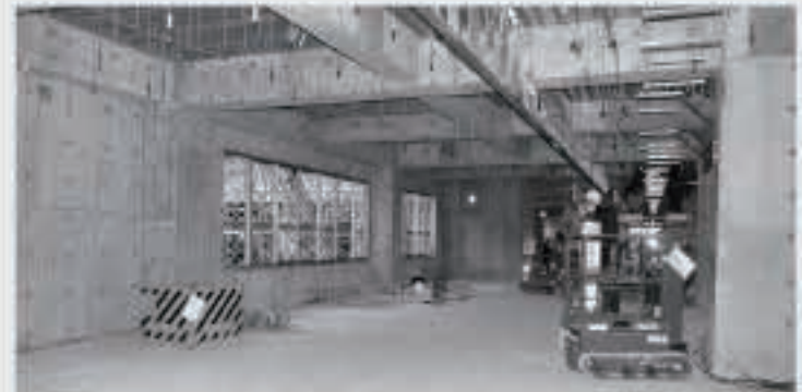
1階内部の様子です。コンクリートが完全に固まり、支柱が撤去されています。今後は、順次内装工事を行います。
