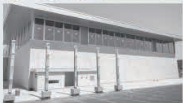
体育館上部の様子。サッシ・窓が入り、壁面も美しく仕上げられています。
