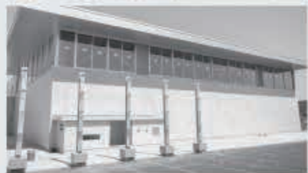
体育館上部の様子。サッシ・窓が入り、壁面も美しく仕上げられています。
