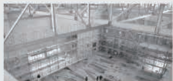
体育館内部の様子。屋根をかけるための内部足場が撤去されています。
