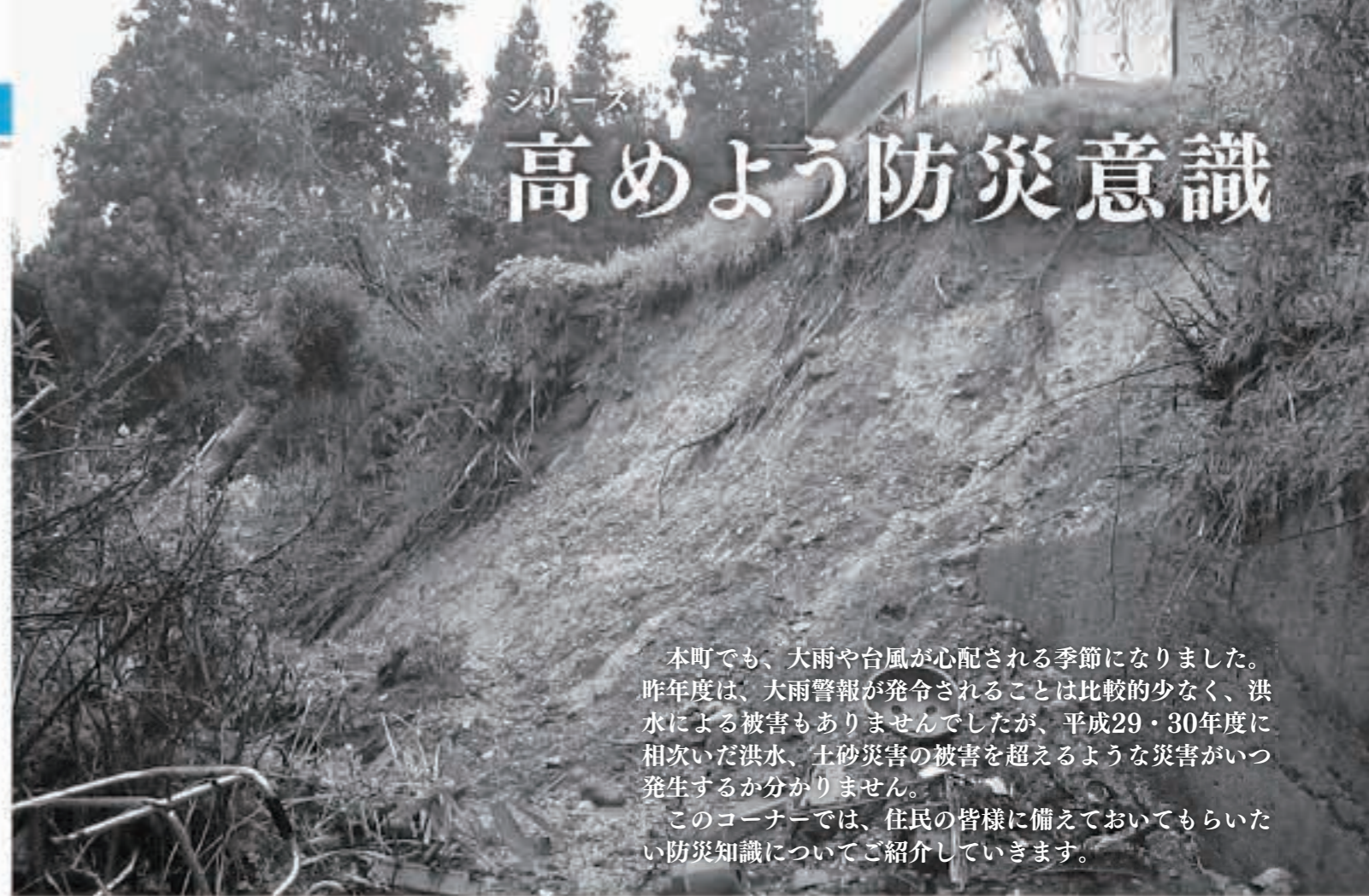
平成30年5月に発生した豪雨災害時の岩野町内の様子。がけ崩れが発生し、土砂や木が斜面を滑り落ちました。
