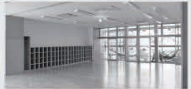
1階は、フローリング・家具の工事が進んでいます。
