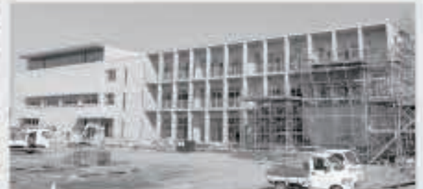
グラウンド側からの様子。足場が外され、教室の様子が見えてきました(左側が体育館、右側が普通教室)。
