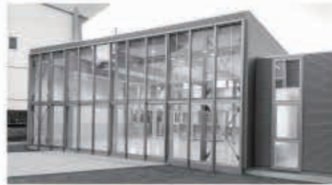
11月末には、五城目小学校新校舎敷地内に学童施設が完成しました。
