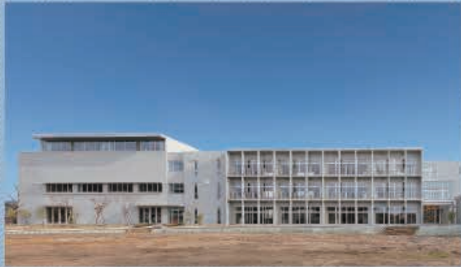
10月30日、五城目小学校新校舎が完成。左側が体育館、右側が普通教室(写真は、グラウンド側から見た新校舎の様子)。
