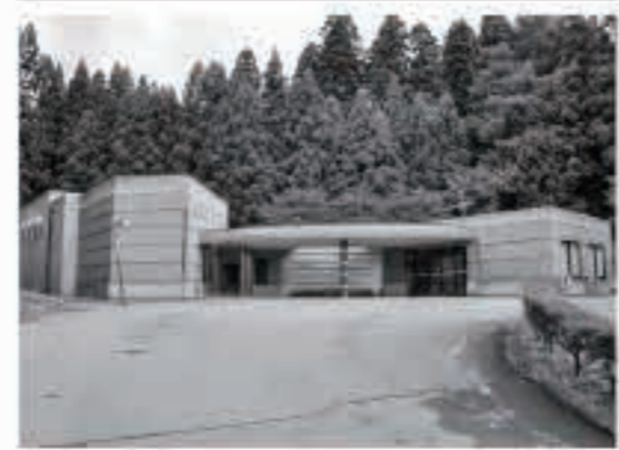
令和4年度までの2か年事業として、老朽化が進む火葬場の大規模改修工事に着手します。
