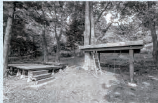
↑完成したツリーデッキとウッドデッキ
