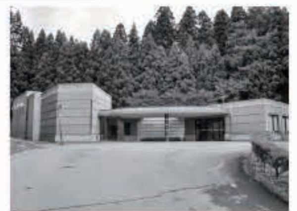
昨年度からの継続事業として火葬場の改修工事を進め、完了は令和5年1月末を予定しています。
