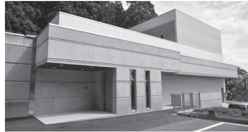
供用開始から30年以上が経過し、老朽化が進む火葬場の大規模改修に着手しました。
