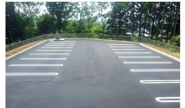
火葬場向かいの町有地を整備し、新たに駐車場敷地を整備。17台分のスペースを設け、合わせて40台が駐車可能です。
