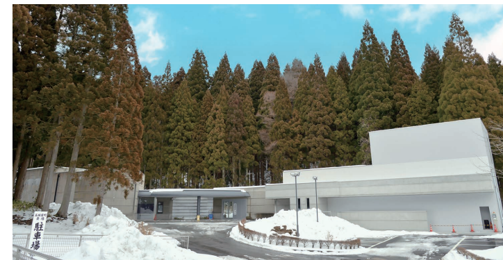
本年2月から全面的な供用を開始した町火葬場。左側が改修を行った既存建物で、右側が新たに増築した建物です。
