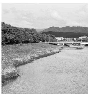
馬場目川の洲ざらい工事の様子
