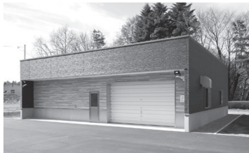
防災備蓄倉庫を整備。
