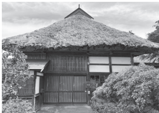
劣化した玄関口などを改修
