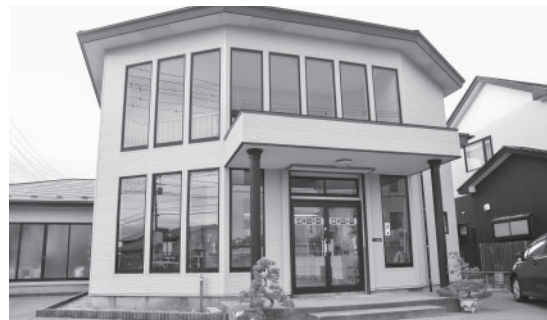
安全確保と事業継続のため外壁を改修
