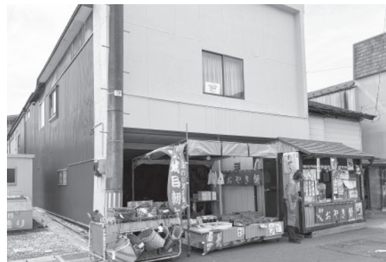
販売所の屋根を修繕
