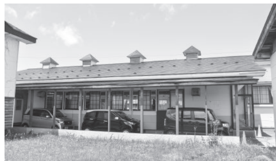
老朽化した屋根を改修
