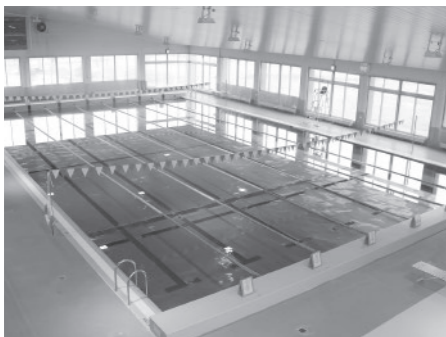
温水プールのプール槽改修工事を実施します。
