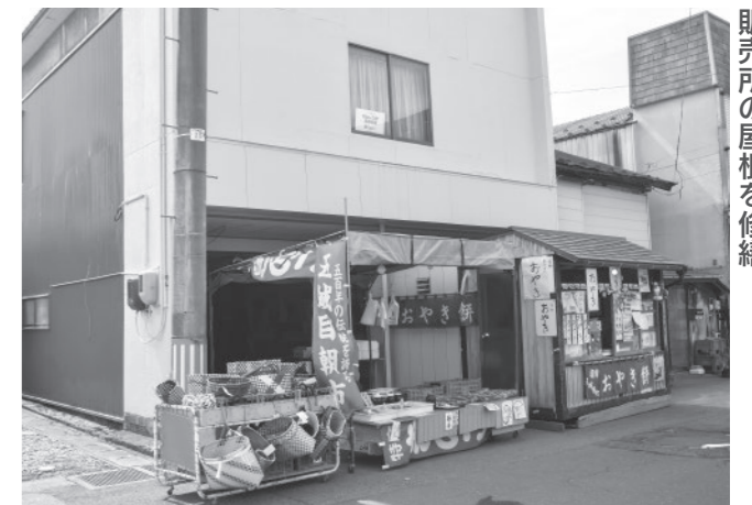
販売所の屋根を修繕
