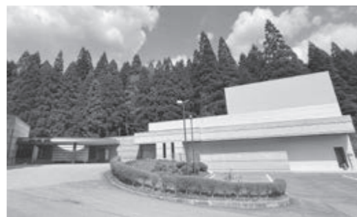
1月に改修した火葬場
